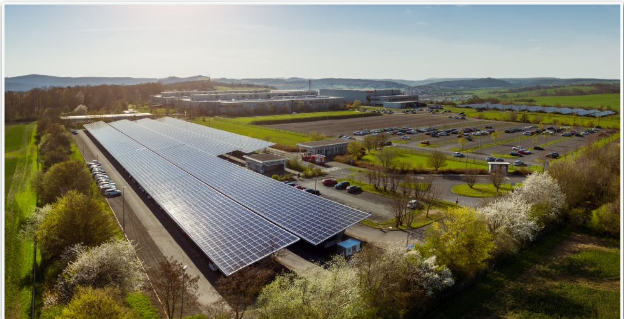
Luftaufnahme Bosch Eisenach mit Teilprojekt PV-Carport; © Robert Bosch GmbH 2021
